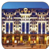
Защита высотных домов и гостиничных комплексов
